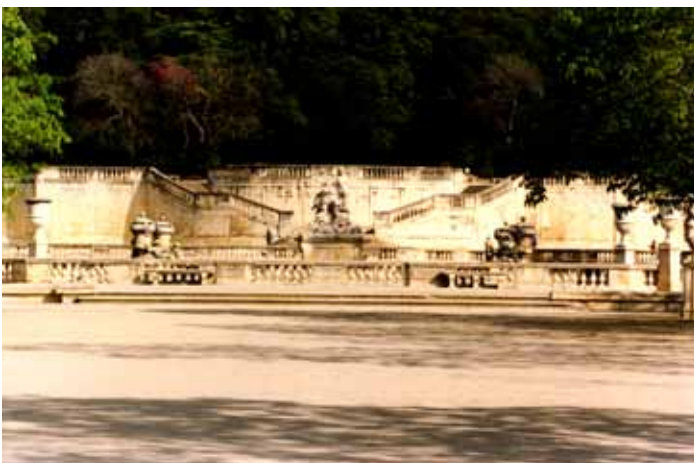
Au Nord, l'unique terrasse réalisée
