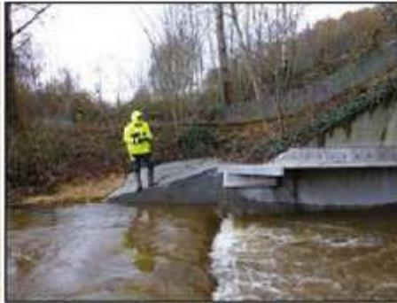
Photos n°24 : Encorbellement en béton polymère, encorbellement achevé dans l'OH et raccordement offrant une possibilité de passage depuis le pied et le haut de berge et ne générant pas un point dur à l'écoulement (de gauche à droite). (© VINCI Autoroutes).
