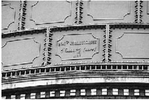
modèle 1885 - panneaux extérieurs de la cuve en fonte
