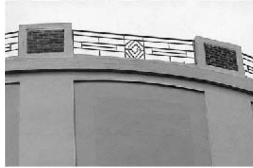
modèle 1930 en béton - extérieur de la cuve et garde-corps
