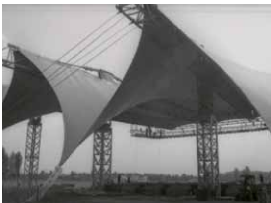
12 - La grande scène depuis les coulisses: le système technique associant toile tendue rouge et grues y est plus lisible
