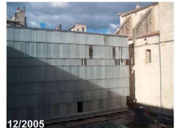
Le pavillon contemporain, dédié aux œuvres de Soulages, ferme la cour Bourdon en vis-à-vis de la façade latérale de Notre-Dame-des-Tables. La paroi du bâtiment est un mur de lumière : une double paroi de verre portée par une charpente métallique et parcourue de tubes fluorescents. A l'extérieur, des plaques de différentes dimensions en verre « bullé » créent un grand motif en relief.
