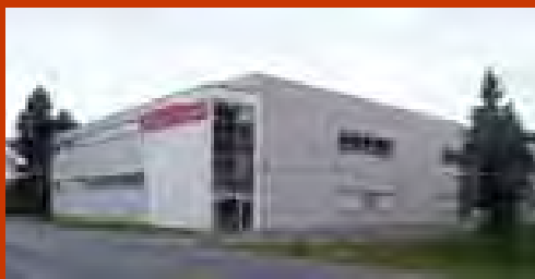
Avant sa rénovation, l'ancien bâtiment dépensait huit fois plus de chauffage qu'aujourd'hui, pour un confort très inférieur.
