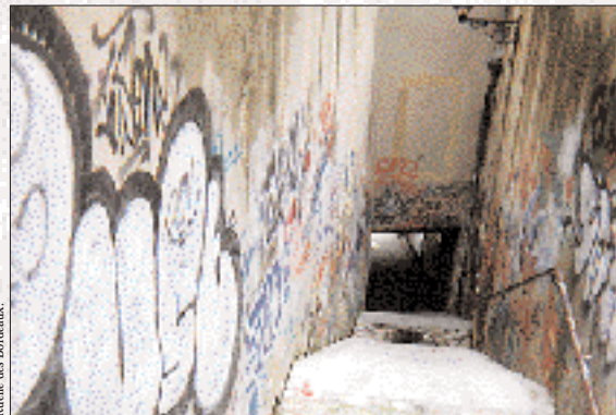
Ruelle des Bordeaux.
